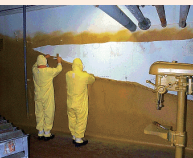
アララSDによる塗膜剥離の様子
