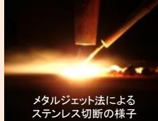
メタルジェット法によるステンレス切断の様子
