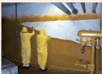
アララSDによる塗膜剥離の様子
